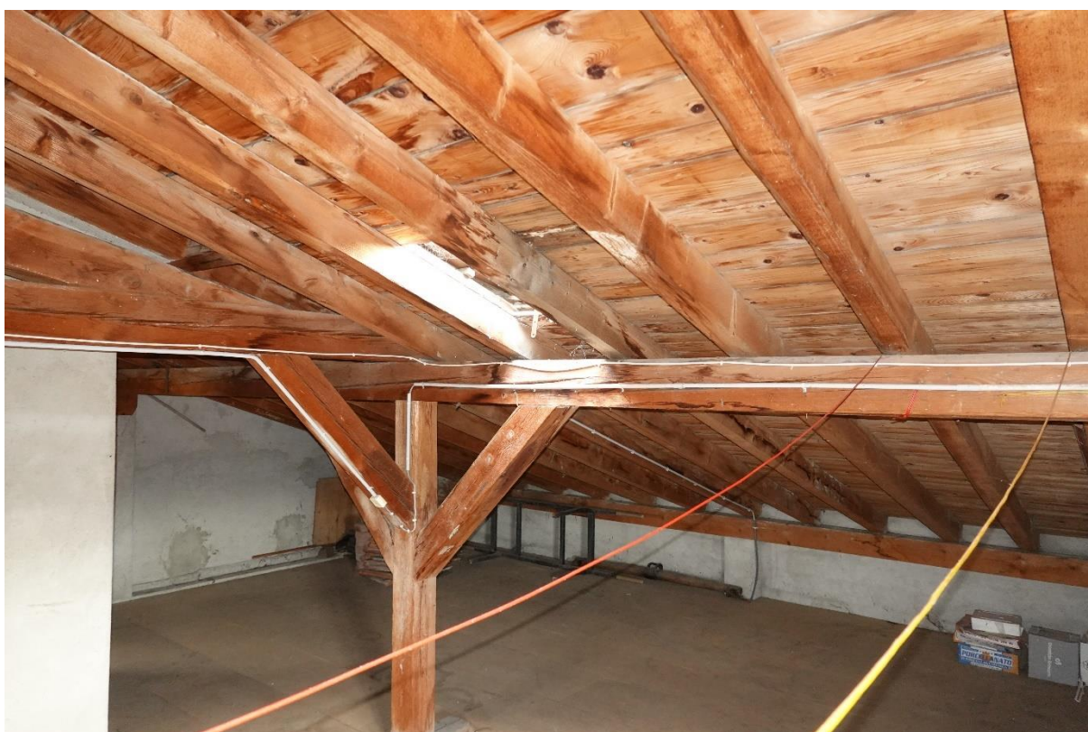
Toiture sur grenier froid
