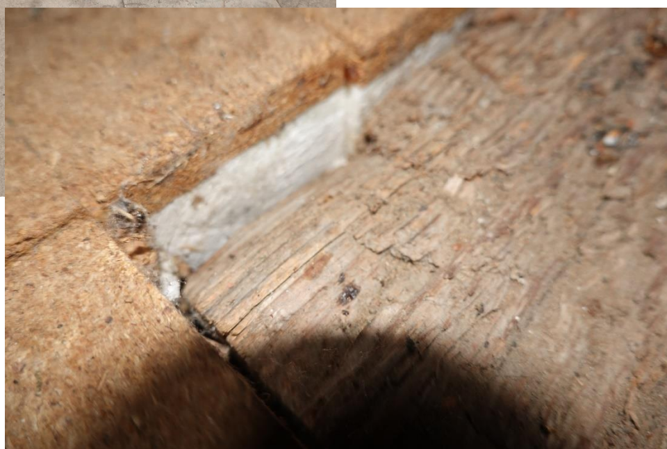
Sol du grenier isolé de ~80mm de polystyrène
