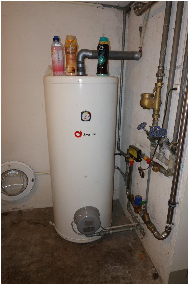
Boiler électrique
