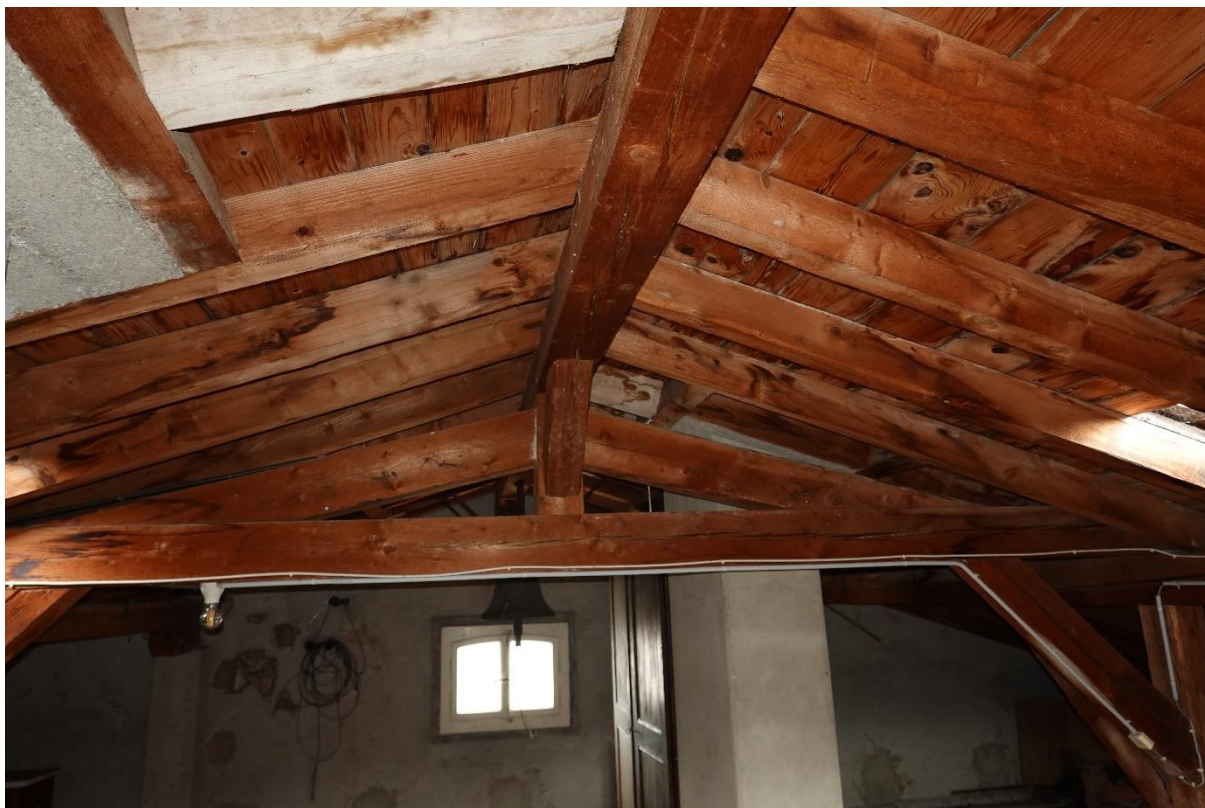
Toiture sur grenier froid
